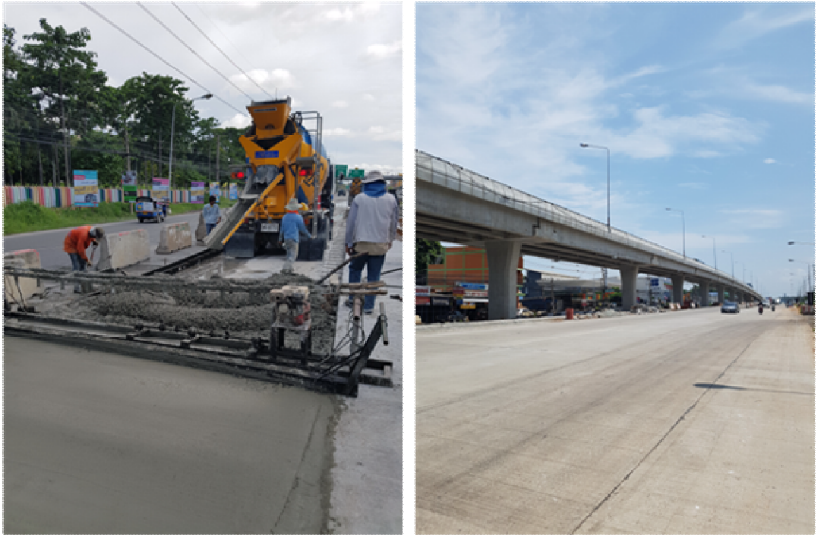
ภาพที่ 8 การก่อสร้าง ทางหลวงหมายเลข 3 ศรีราชา – อ่าวอุดม, การเทคอนกรีต (ซ้าย) ผิวทางคอนกรีตหลังดำเนินการแล้วเสร็จ (ขวา)
