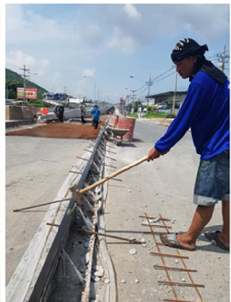
ภาพที่ 7 การตั้งแบบคอนกรีต ทางหลวงหมายเลข 3 ศรีราชา – อ่าวอุดม, การเจ้าน้ำด้วยสว่าน (ซ้าย) การตอกหมุดยึดแบบคอนกรีต (ขวา)
