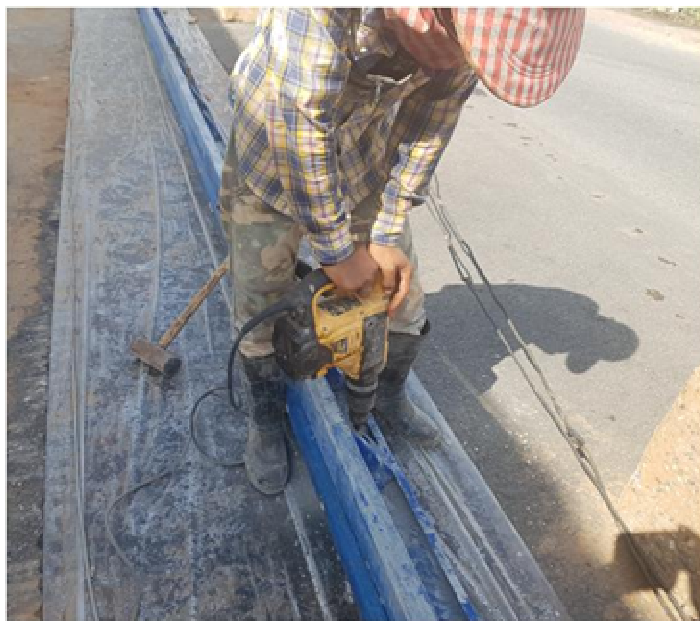
ภาพที่ 7 การตั้งแบบคอนกรีต ทางหลวงหมายเลข 3 ศรีราชา – อ่าวอุดม, การเจ้าน้ำด้วยสว่าน (ซ้าย) การตอกหมุดยึดแบบคอนกรีต (ขวา)
