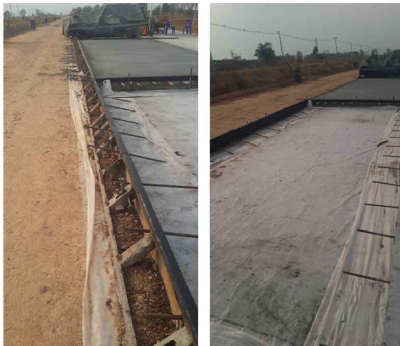
ภาพที่ 10 การเตรียมการก่อสร้างถนนคอนกรีตโดยใช้แผ่นใยสังเคราะห์สำหรับรองผิวทางคอนกรีต (Geotextile)
